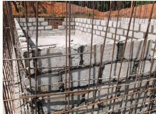
Réservoir construit, filtre à sable en construction (à droite)
